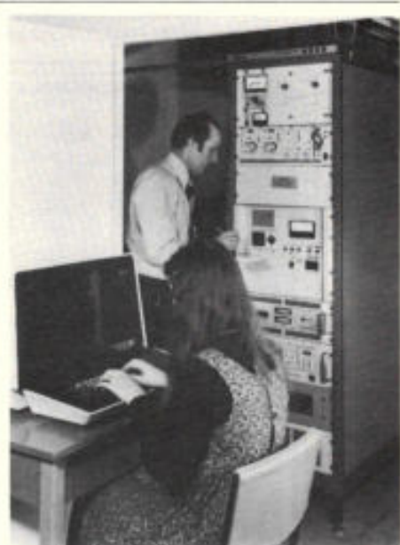
Afb. 2. Deze grondstationapparatuur schijnt een wezenlijk deel te worden van menig computercentrum. De apparatuur wordt met een kleine antenne gebruikt om laboratoria op het gebied van kernonderzoek in verschillende delen van Europa te verbinden.
